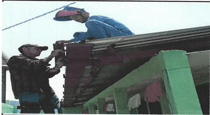
Foto1: Los canales se encuentran en proceso de sustitución para que el fluido del agua pluvial no afecte por la humedad
