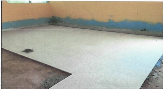
Foto 3: El piso se encuentra en proceso de intalación el cual se encontraba malas condiciones debido a grietas y levantado del mismo
