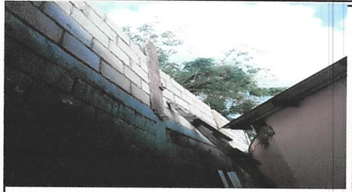
Foto 2: El muro perimetral esta en proceso de reparación por la altura del mismo y expuesto a las instalaciones del establecimiento.
