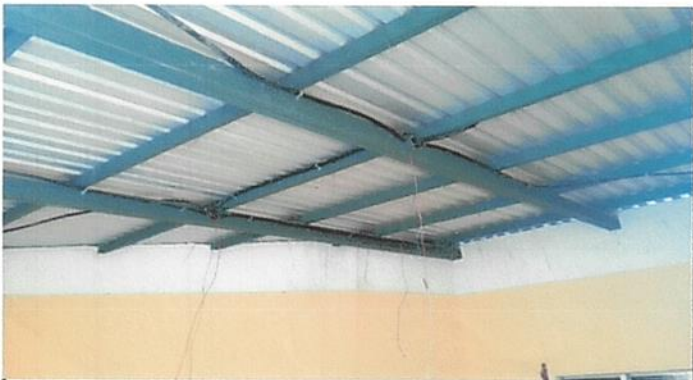
Foto 5: El area de lamparas y cableado en interiores de las aulas se encuentran en proceso de instalación debido a que encontraba en malas condiciones y la falta de iluminación en los ambientes de las aulas.
