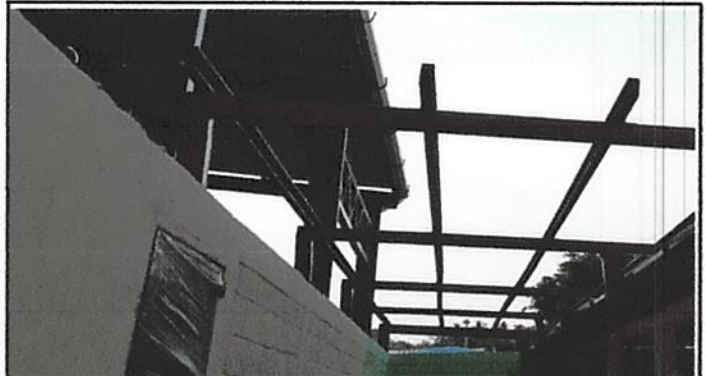
Foto 8: La estructura del soporte de metal se encuentra en proceso de instalación debido a que esta se encontraba en malas condiciones debido al deterioro de la misma.
