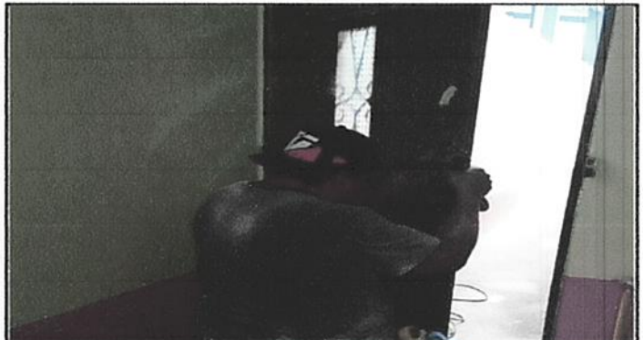
Foto 10: La sustitución de la chapa de puerta de metal se está realizando debido al deterioro de la misma.
