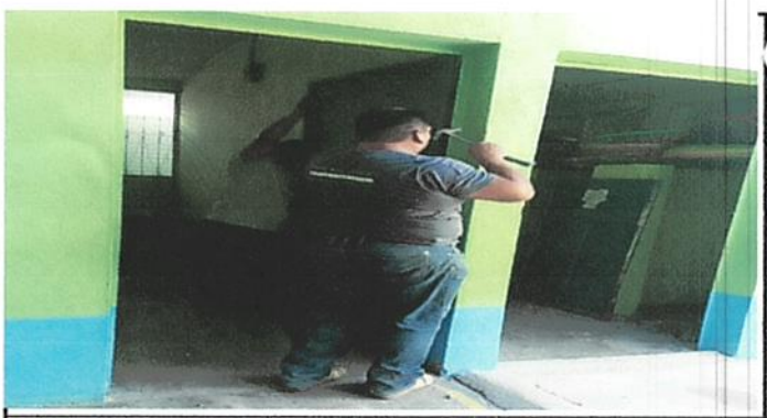
Foto 6: Las puertas se encuentran en porceso de mantenimiento tanto en aulas y areas de sanitario las cuales se encuentran dañadas por factores a causa de humedad y deterioro por corrosión en la estructura.
