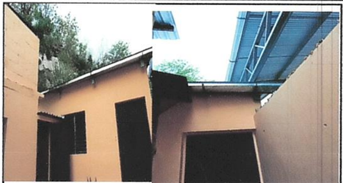
Foto 14: Se está llevando a cabo el cambio de canales los cuales se encuentran deteriorados y se dificulta el flujo del agua pluvial.
